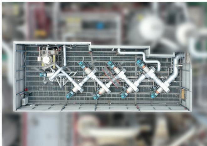
Tecnología de bomba de calor de compresión de vapor: compresión de vapor con conexión en serie de ocho VapoFlex
