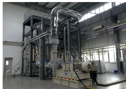
PILLER 自家的 MVR 工厂里的降膜式蒸发器
